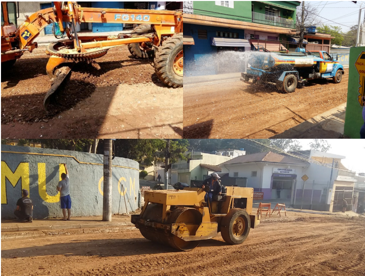
Figura 47 - Sequência de execução de uma subbase de pavimento flexível com bica corrida reciclada.
