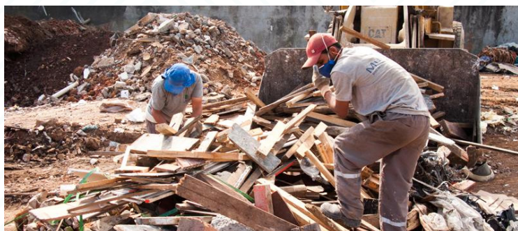
Figura 6 – Catação no chão ou em pilhas de RCD feita por operários numa ATT. Geralmente é menos eficiente que a triagem em transportadores de correia.
