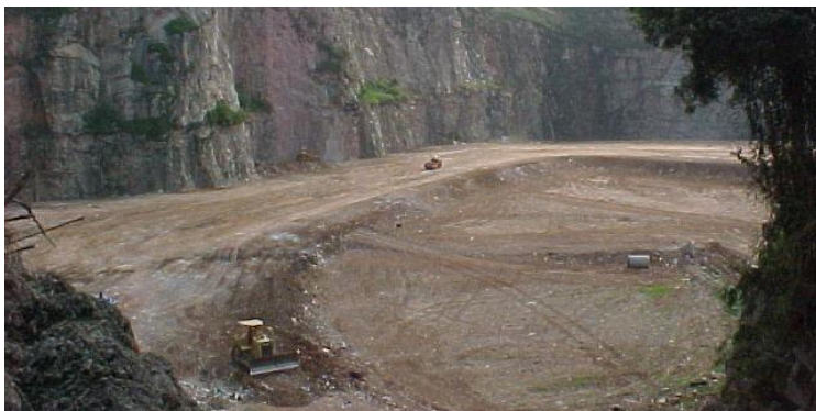
Figura 9 - Operação de um aterro de resíduos "inertes" da construção civil, na região metropolitana de São Paulo. Fonte: Sérgio C. Angulo [2007].
