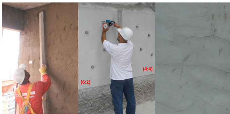
Figura 51 – Ensaios de arrancamento que medem a resistência de aderência e testes de fissuração são realizados normalmente em obras, antes de se adotar ou padronizar um procedimento de execução da argamassa de revestimento numa construtora. Esse tipo de tecnologia é afetado pelo treinamento da mão-de-obra. Recomenda-se uso apenas como revestimento interno. Fonte: Alexandre Brites.
