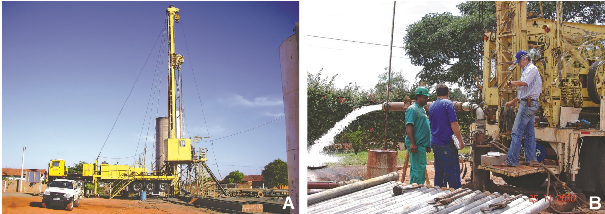
Figura 1.9. A. Execução de sondagem para extração de água subterrânea. B. Execução de teste de bombeamento em poço para captação de água subterrânea. Fotos: Júlio César A. Perrone.
