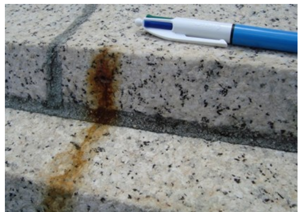
Figura 14.13. Mancha da pedra devido à oxidação de minerais opacos (magnetita, pirita e outros), Monumento à Independência, São Paulo. Foto: Wilian C.B. Augusto.
