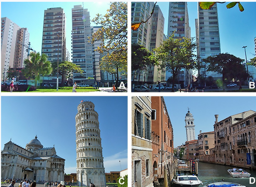
Figura 13.7. Adernamento de edifícios. A e B. Orla de Santos. C. Torre inclinada da Catedral de Pisa, Itália. D. Veneza, Itália. Fotos: Eliane A. Del Lama.
