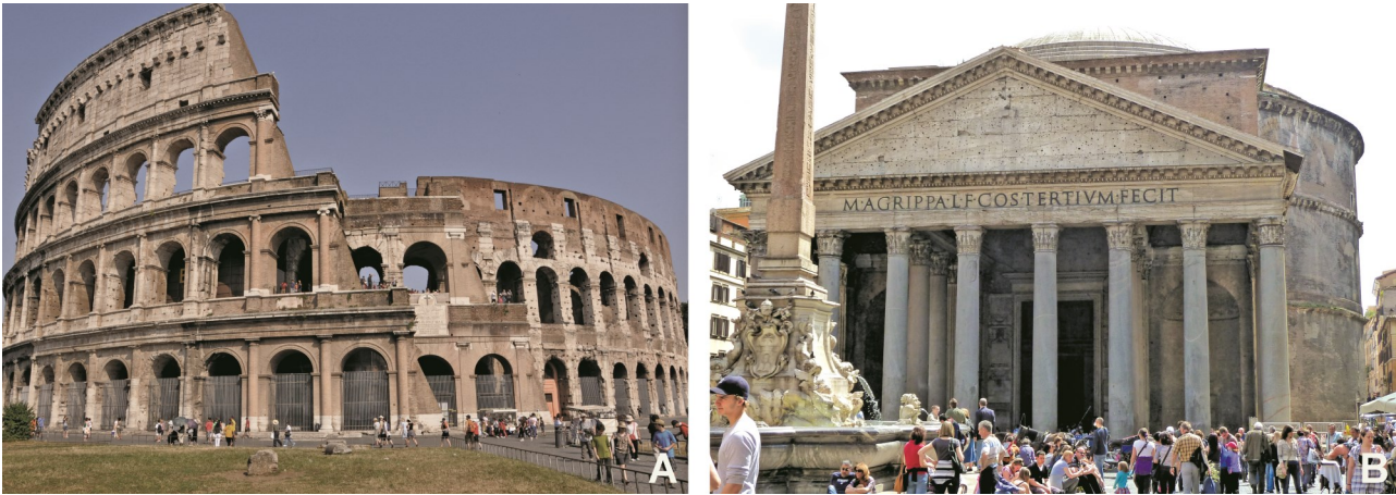
Figura 14.24. A. Coliseu de Roma construído em Travertino Romano, com argamassa do tipo cimento romano. B. Pantheon, com colunas de Granito del Foro, triângulo em Travertino Romano, e cúpula, na parte posterior do prédio, em concreto (cimento romano), Roma, Itália. Fotos: Lauro K. Dehira.
