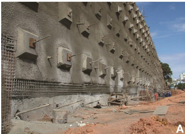
Figura 1.4. A. Execução de cortinas atirantadas. Via expressa de acesso ao porto de Salvador. B. Execução de um canal de drenagem subterrâneo. Via expressa de acesso ao porto de Salvador. Fotos: Lauro K. Dehira.
