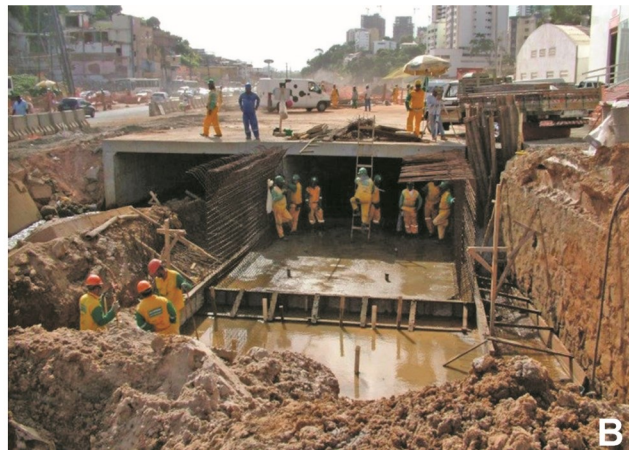
Figura 1.4. A. Execução de cortinas atirantadas. Via expressa de acesso ao porto de Salvador. B. Execução de um canal de drenagem subterrâneo. Via expressa de acesso ao porto de Salvador. Fotos: Lauro K. Dehira.
