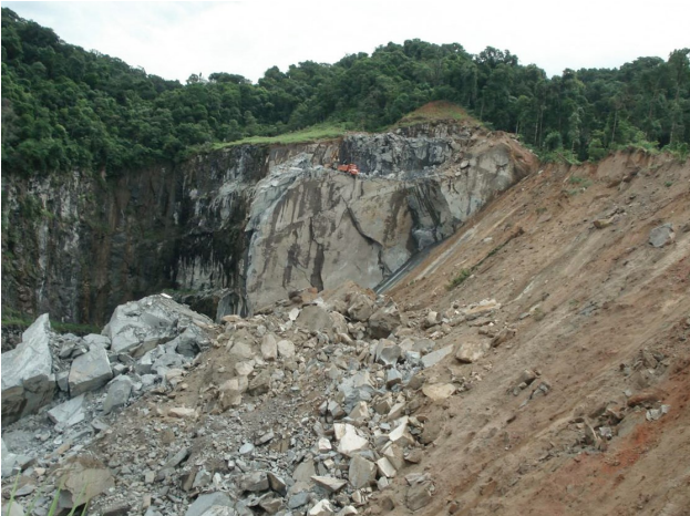
Figura 1.6. Deslocamento em cunha em frente de pedra em Santos. Notar o tamanho do caminhão vermelho no centro da foto. Foto: Lauro K. Dehira.
