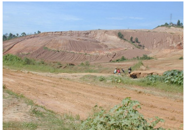
Figura 1.10. Morro submetido a trabalho de terraplanagem. O solo observado é produto de alteração de rochas do substrato. Foto: Arquivo IPT.
