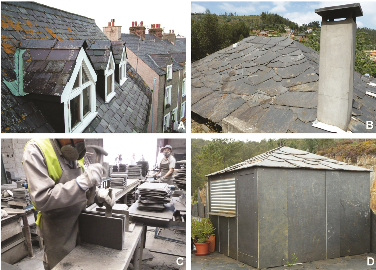
Figura 14.12. Utilização e extração da ardósia. A. Telhado em Comwy, Inglaterra. B. Telhado no Centro de Interpretação Geológica de Canelas. C. Oficina de preparação de lajes de ardósia. D. Quiosque com paredes e telhado em ardósia. B a D Arouca, Portugal. Fotos: Eliane A. Del Lama.
