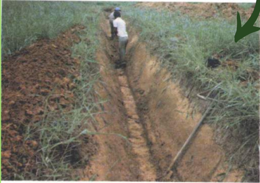
FOTOGRAFIA ESCAVAÇÃO DE VALETA
