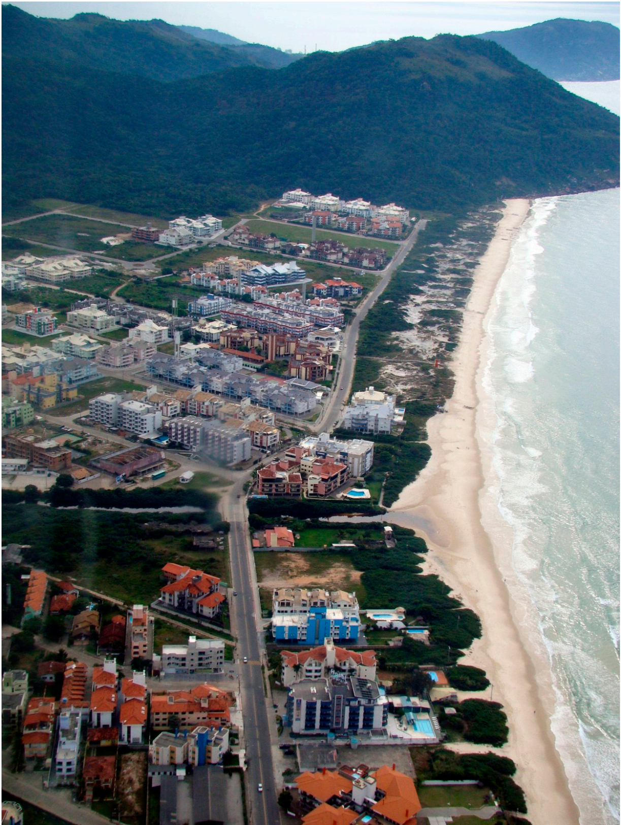
Figura 8.27 – Urbanização da Praia dos Ingleses em Florianópolis, empreendimento baseado na verticalização moderada, ocupa toda a área de restinga vizinha à praia, que tem sua área mais ou menos íntegra.
