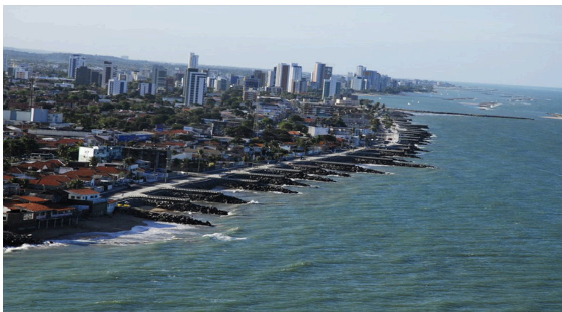
Figura 3.14 – Obras de engenharia construídas para o controle da erosão costeira ao longo da orla da Região Metropolitana de Paulista, Recife, Olinda e Jaboatão dos Guararapes.
