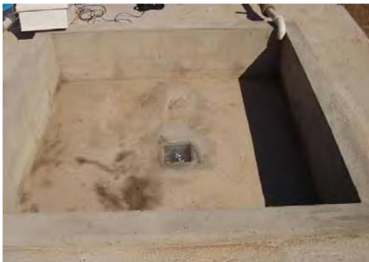
Figura 1. Reator solar quadrado para desinfecção de efluente doméstico (SÁNCHEZ ROMÁN et al. , 2007).
