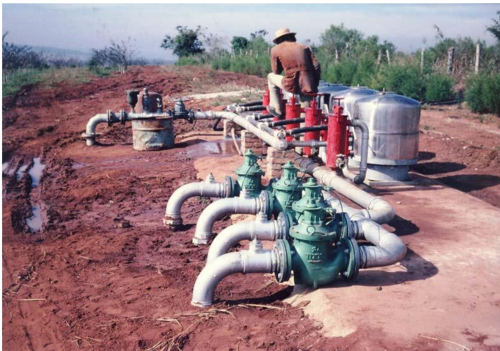
Figura 5. Cabeçal de controle (medição de água, filtragem e fertirrigação) de sistema de irrigação por gotejamento para 122 hectares de cultivo de ameixa, município de Buri (SP), ano de 1978.
