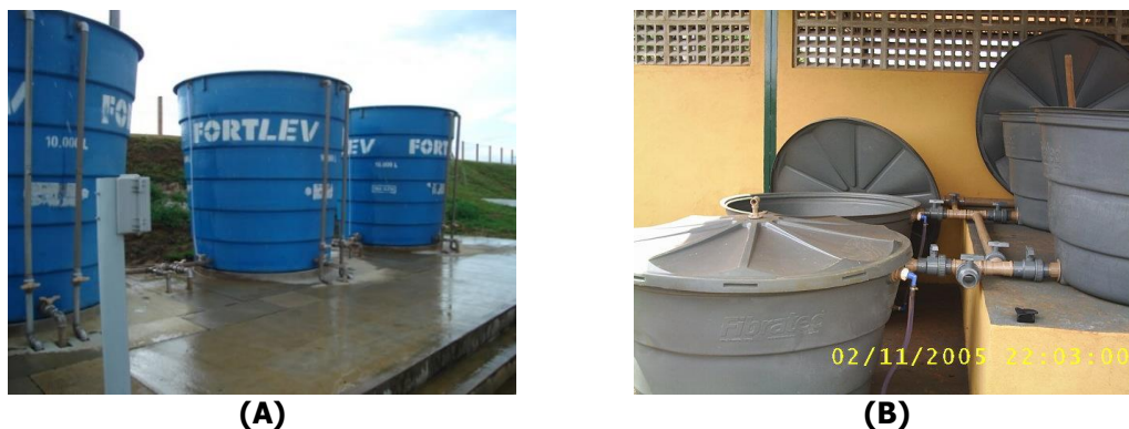
Figura 3. Disposição das caixas de diluição (A) e injeção (B) em sistema de fertirrigação (ANDRADE, 2010).
