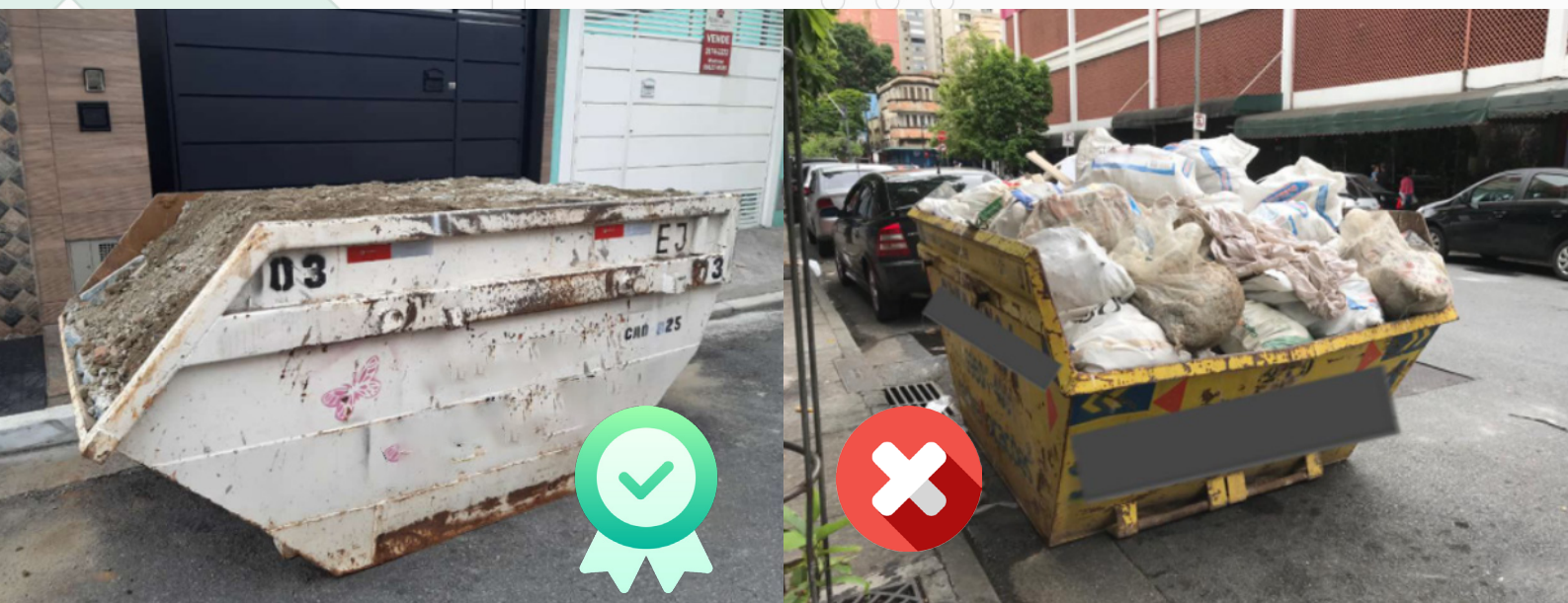
(a) Caçamba preenchida corretamente, volume de resíduos adequado à sua capacidade
