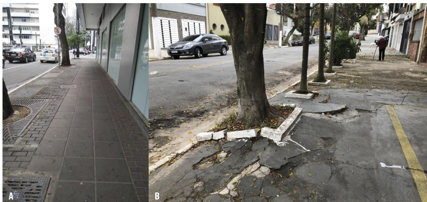
Figura 26 Dois exemplos de arborização na calçada. À esquerda (A), as árvores não interferem na qualidade do pavimento da faixa livre de circulação de pedestres. À direita (B), as raízes das árvores estão soerguendo o pavimento da calçada.
