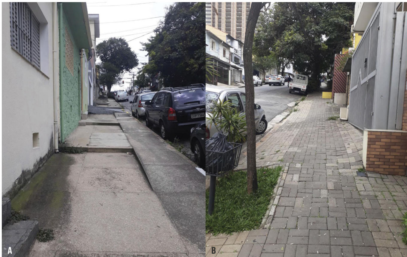
Figura 13 Fotografias de calçadas opostas, localizadas na mesma rua. Na imagem A, a calçada tem degraus que dificultam a caminhada. Na imagem B, a calçada foi nivelada em rampas para compatibilizar inclinações longitudinais e transversais.
