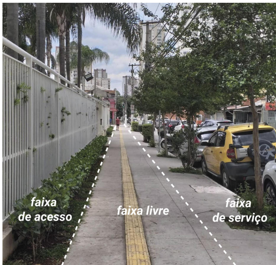
Figura 9 Segmentação das faixas de uma calçada: faixa livre de circulação, faixa de serviço e faixa de acesso.
