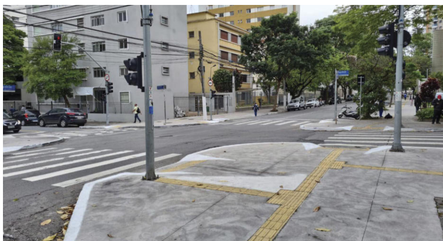
Figura 28 Exemplo de esquinas estendidas, com ampliação da área de calçada e redução da largura do leito carroçável, para facilitar a travessia de pedestres.
