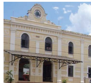
ESTAÇÃO DE TREM Estrada de ferro garantiu escoamento da produção
