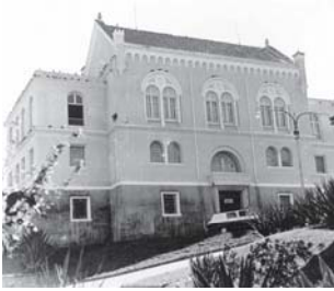
CÂMARA MUNICIPAL Prédio histórico projetado por Euclides da Cunha
