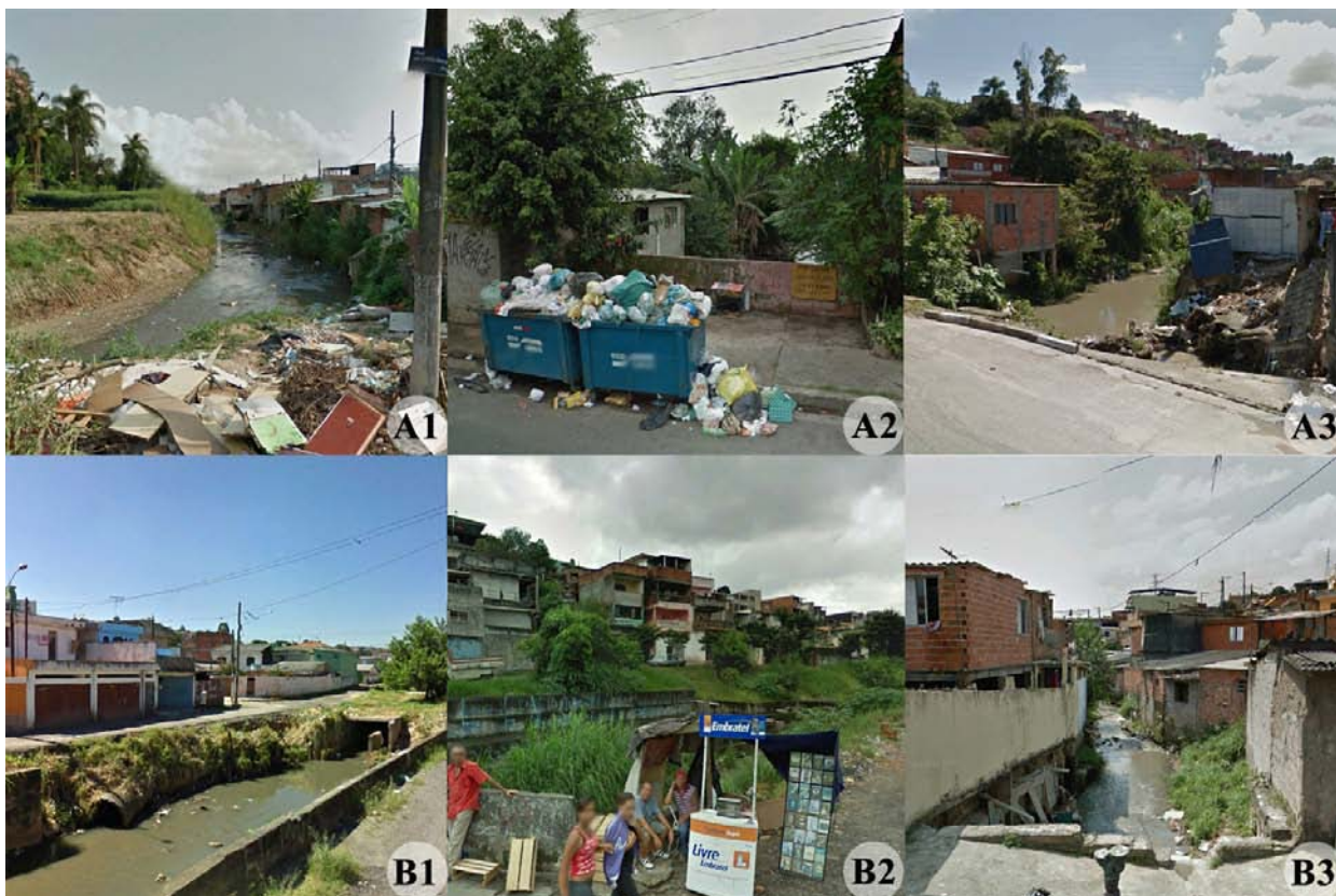
Imagem 6: A1, A2 e A3: Córrego Moenda Velha. B1, B2 e B3: Córrego Água dos Brancos. Imagens mostrando as ocupações às margens dos córregos e referenciadas no mapa da Imagem 7 | Fonte: Google Earth 2016 | Elaboração: Jéssica Ragonha.
