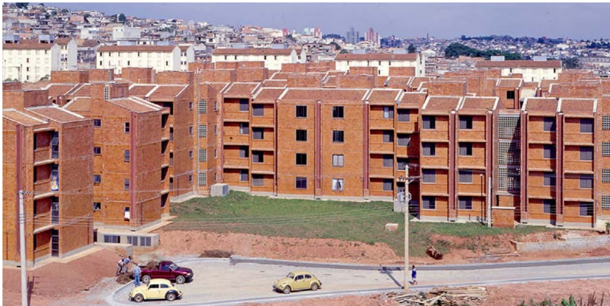
Imagem 04 - Construção União da Juta. Fonte: Usina CTAH
