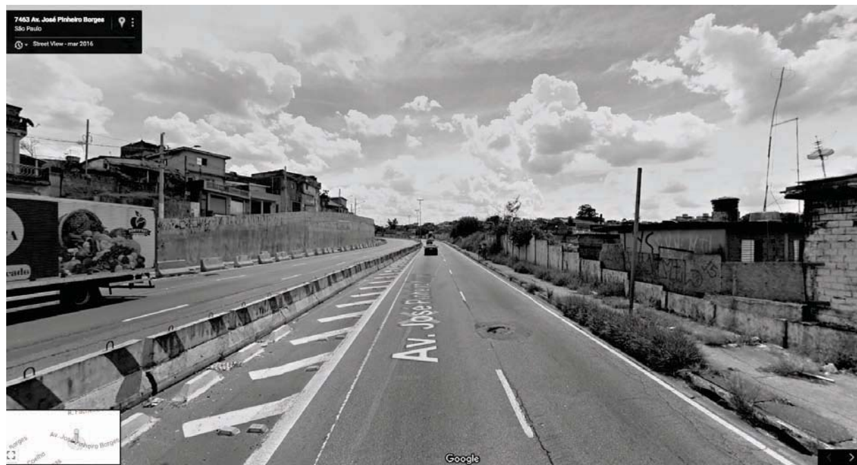
IMAGEM 05 - Avenida Radial Leste (2016). Fonte: Google Street View 2016.
