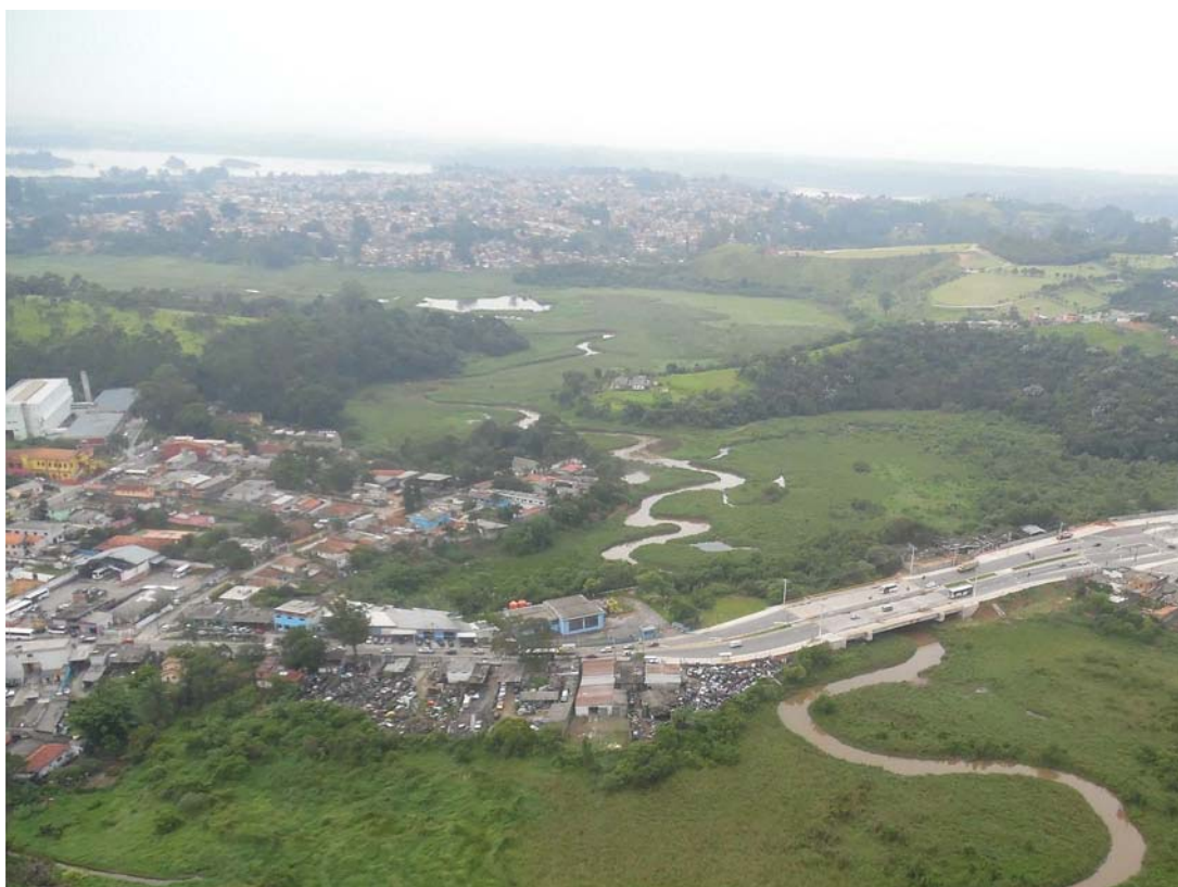
Figura 4 – Ponte sobre o Rio M'Boi Mirim no distrito do Jd. Ângela em M'Boi Mirim. Fonte: Defesa Civil Subprefeitura M'Boi Mirim. Foto: Simone da Silva.
