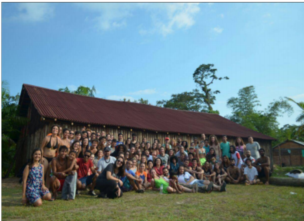
Figura 4 - “ Opy’i ” (Casa de Reza) construída pela parceria do Projeto de Extensão e o T.I. do Rio Silveiras, Bertioga, São Paulo/BR.
