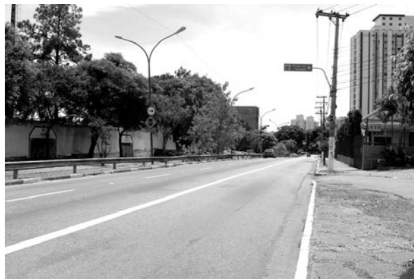
FIGURA 18 Avenida Condessa Elizabeth de Robiano, imediações do Parque São Jorge, 2017: trecho de viário existente que deverá ser apoio para a implantação da Estrutura de Contorno/ Linha Sul.
