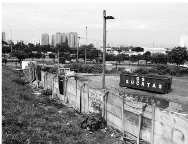
FIGURA 20 Ocupação residual ao longo da Marginal Tietê, a partir da Ponte Julio de Mesquita Neto, 2015. Observar a acomodação de nível do terreno na ancoragem da ponte e o tipo de ocupação residual junto à cabeceira da Ponte e ao longo da Marginal Tietê.
