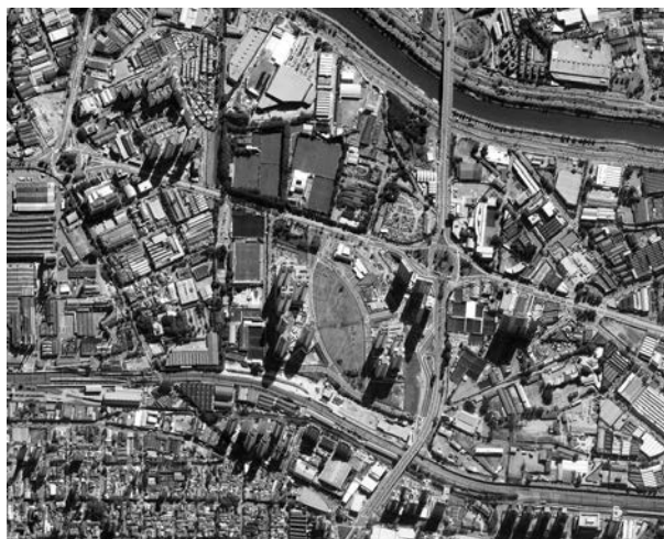
FIGURA 38 Trecho da área Operação Urbana Consorciada Água Branca: Imagem Aérea, 2017. Observar a justaposição entre tecidos de ocupação industrial/ logística, a dimensão das glebas existentes e alguns empreendimentos imobiliários recentes, caracterizados por lotes extensos e edifícios de elevado gabarito, viabilizados após o lançamento da Operação Urbana. O empreendimento imobiliário Jardim das Perdizes e a área livre pública disponibilizada pelo loteamento destacam-se no centro da imagem.
