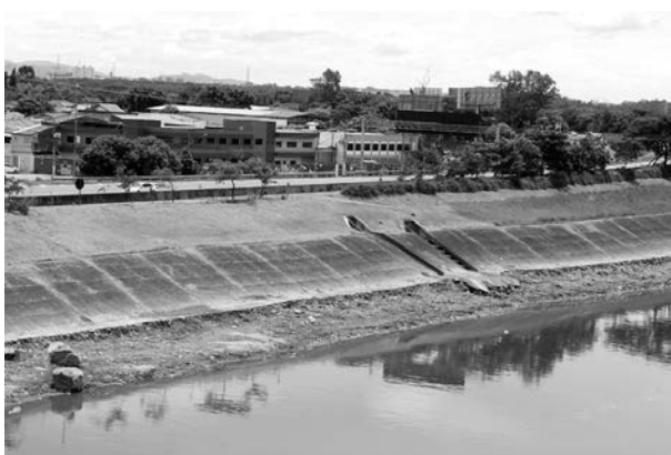
FIGURA 25 Canal Viário Tietê, a partir da Ponte Imigrante Nordeste, imediações da divisa com o Município de Guarulhos, 2017. Observar o talude revestido de concreto e o nível inferior da berma, que deve ser estendido em direção à atual Avenida Marginal; observar que a ocupação ao longo do Rio está em nível inferior às avenidas que, nesse trecho, funcionam como dique.
