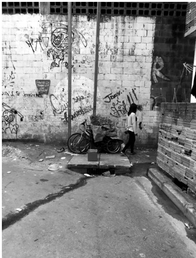
FIGURA 20 Parque Novo Mundo: trecho final de via e linha de infraestrutura de drenagem e esgoto, 2017. Observar o ponto final da rede de captação junto à divisa de grande gleba murada e como a “caixa” encontra-se em nível ligeiramente inferior ao greide da via.
