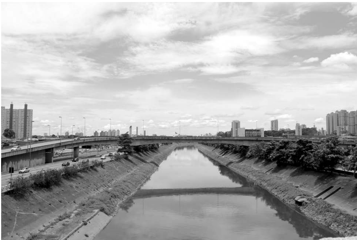
FIGURA 49 Canal Viário Tietê a partir da Ponte Tatuapé, 2017.
