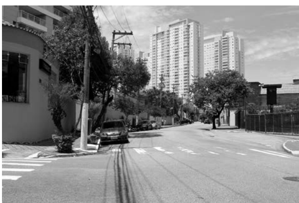
FIGURA 14 Padrão de transformação urbana recente na Várzea do Tietê, 2017: empreendimentos residenciais verticalizados sobre glebas extensas, características da estrutura fundiária da área. Observar a presença dos tipos de ocupação: estacionamento/comércio extensivo, pequenas construções de uso misto e condomínios residenciais.
