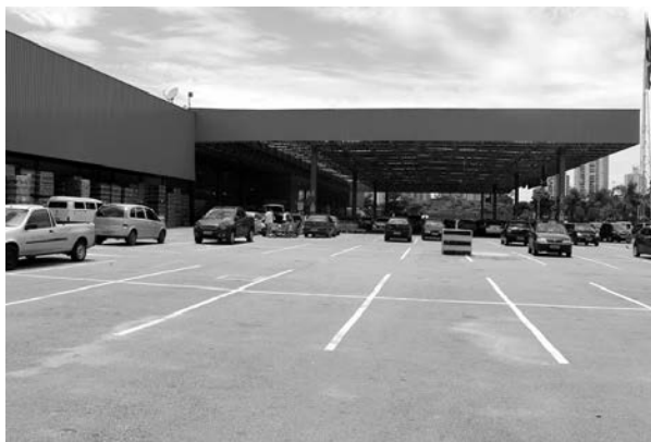
FIGURA 19 Tipo de ocupação de comércio extensivo, recorrente na Várzea do Tietê, 2017. Observar a excessiva impermeabilização do solo por pavimentação asfáltica.
