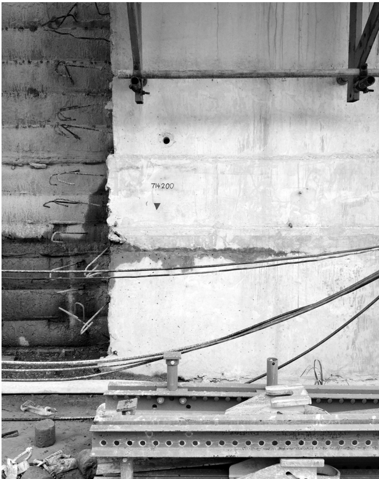
Identificação de nível para execução da obra Eclusa da Penha, 2015.
