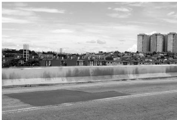
FIGURA 5 Várzea do Tietê: ocupação marginal ao rio, a partir da Ponte Imigrante Nordestino, 2017. Observar a diferença de nível entre o tabuleiro da ponte e a cota de implantação das construções.
