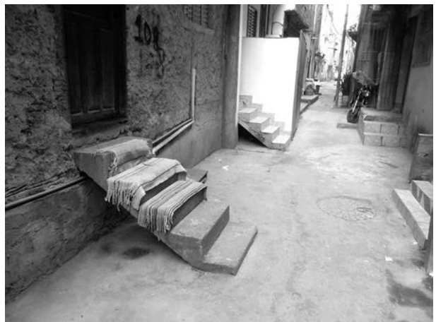
FIGURA 19 Parque Novo Mundo: trecho de uso residencial, próximo às grandes glebas elevadas, 2017. Observar como o nível das casas foi elevado em relação ao acesso, em função das periódicas inundações.
