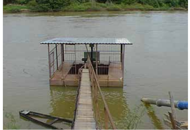
Captação em rio, em sistema flutuante
