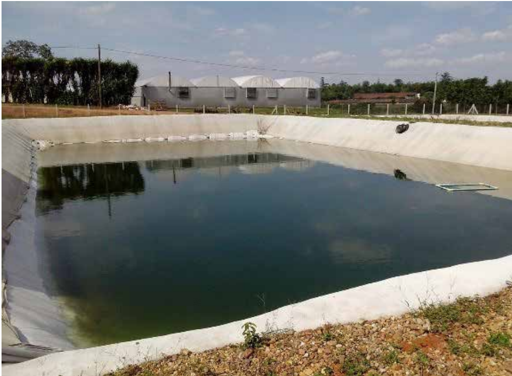
Reservatório para armazenamento da água da chuva
