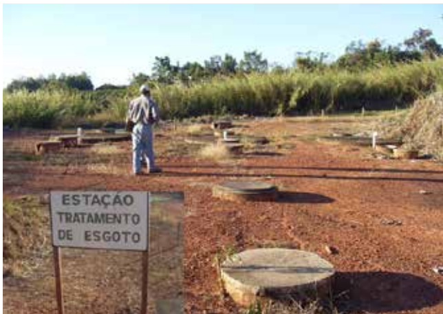
Estação de tratamento de esgoto
