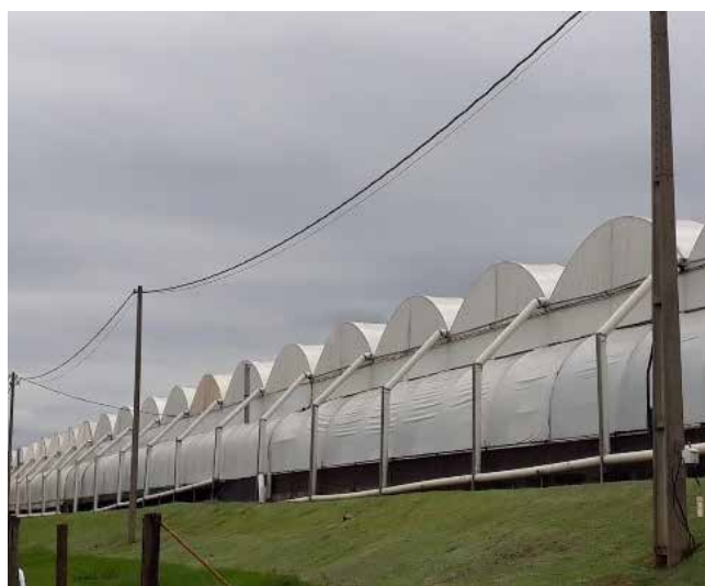
Tubulação para coleta da água da chuva
