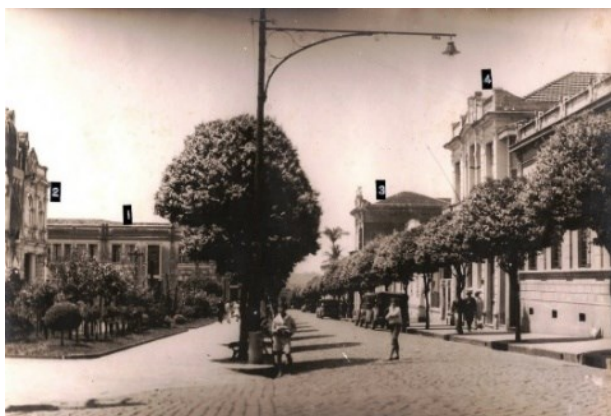
Figura 5 – Vista parcial da Rua São Bento. 1 - Hotel Municipal; 2 - Clube Araraquarense; 3- Banco do Comércio e Indústria S/A.; 4- Associação Comercial e Industrial de Araraquara. Foto de 1930. Fonte: Museu da Imagem e Som "Maestro José Tescari" (Prefeitura Municipal de Araraquara).
