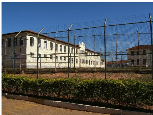
Figura 2 – Escola Prática de Agricultura “Gustavo Capanema”, Bauru-SP. Atualmente Centro de Progressão Penitenciária “Prof. Noé de Azevedo”. Edifício neocolonial e grades de proteção.
