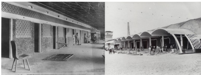
Figura 18 – Estação Rodoviária em construção.
