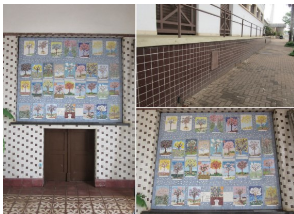
Figura 20 – Azulejos da estação.
