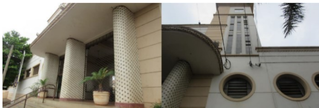
Figura 14 – Entrada para o saguão e torre. Fonte: da autora, 2020.
