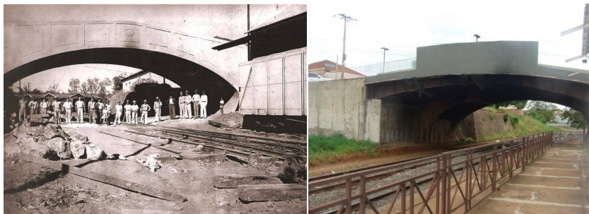
Figura 10 – Viaduto em construção e viaduto antes do rebaixamento.
