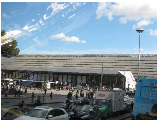
Stazione Roma Termini
