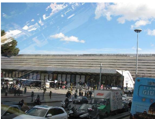
Stazione Roma Termini
