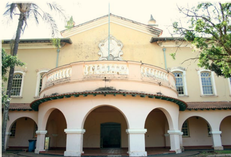
Figura 1. Fachada do Ginásio do CEFER USP Ribeirão Preto.
