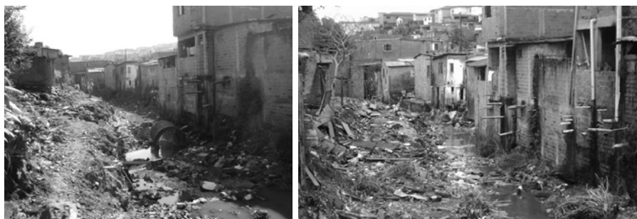
Fig. 102 – Imagens do córrego do Sapé antes da canalização. Fonte: Blog Micro Rede Sapé (2012). http://microredesape.blogspot.com.br/
