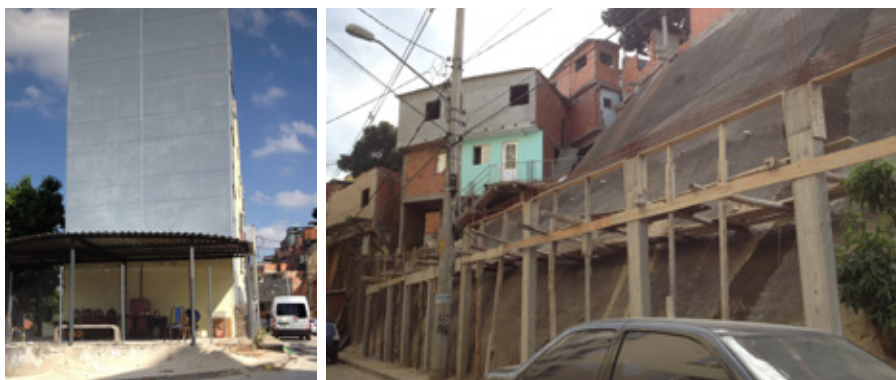
Fig. 69 – Reocupação de talude. Crédito: Miguel Bustamante (2015).
