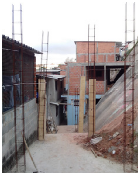
Fig. 62 – Reocupação de taludes. Crédito: Maria de Lourdes Zuquim (2013).
