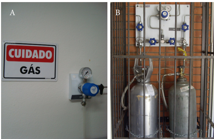
Figura 3. A) Adaptadores para gás \text{O}_2 e \text{CO}_2 ; B) Cilindros localizados na área externa do Biotério
