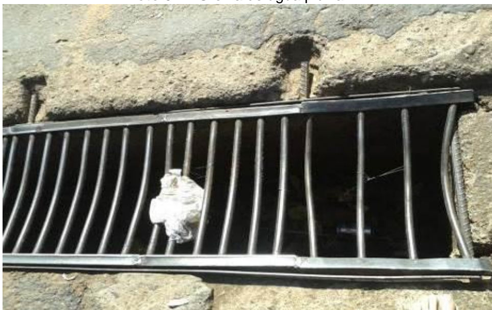
Foto 01 – Grelha de água pluvial.
