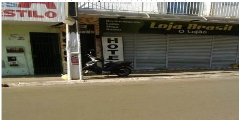
Foto 04 – Calçada como estacionamento.
