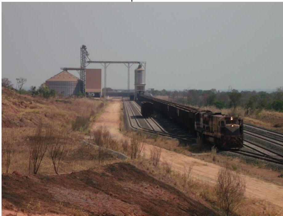
Figura 02 – Ponto de escoamento de grãos interligado a Plataforma multimodal construído na TO-335 entre os municípios de Palmeirante e Colinas do Tocantins.
