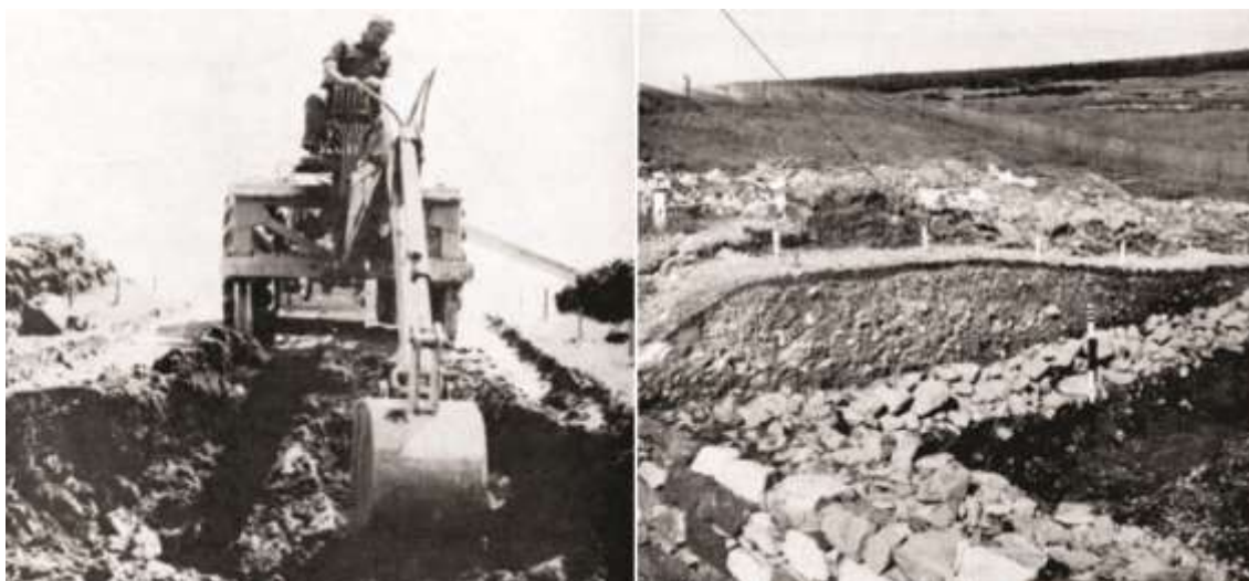
Fig. 1. À esquerda, abertura de trincheira através do uso de maquinário com deposição do sedimento nas laterais da mesma; à direita, perfil de uma das trincheiras abertas com a máquina e limpa manualmente (Walker 1967: 14 e 16).
