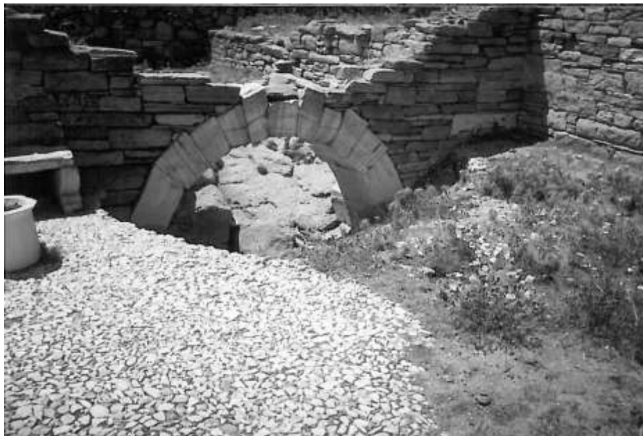
Arco de entrada para a Cisterna na área B. (Almeida, 2015: 142)
