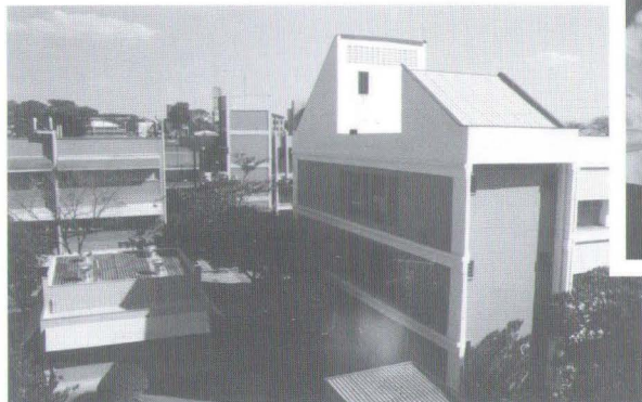
Vista externa da nova biblioteca do IQSC
