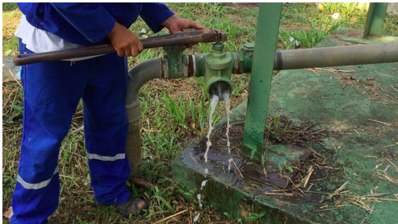
Figura 7.5 – Coleta da água imediatamente na saída do poço.
