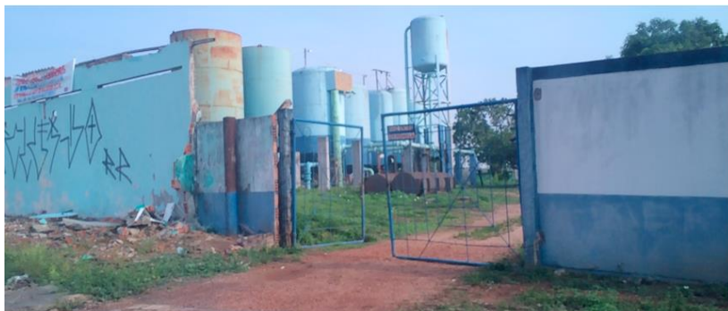
Figura 7.6 – Estação de Tratamento de Água de Liberdade (ETA Liberdade).
