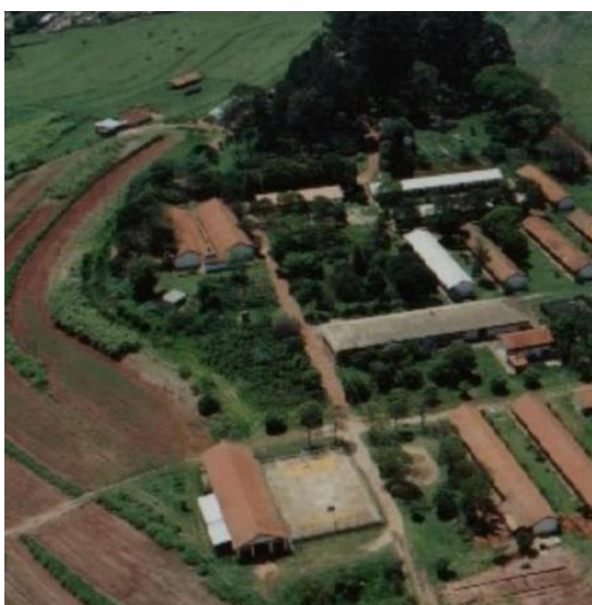
Figura 2: Imagem área da ETEC José Coury
