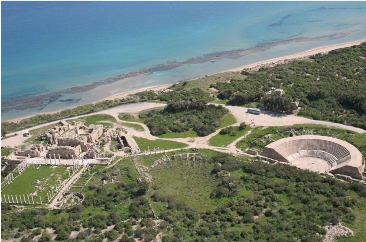
Fig. 78: Fotografia aérea mostrando uma parte da espaçosa cidade de Salamina; à esquerda, o grande complexo de ginásio e banheiros, à direita, o teatro e, no espaço entre eles, alguns restos escassos do anfiteatro.
