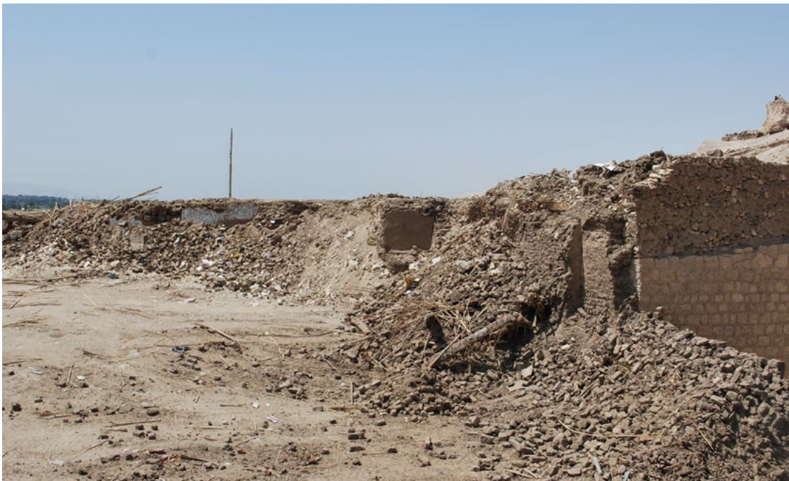
Fig. 6 – Escombros de casas qurnawis, Khoha 2009. Fonte: Fotografia José Roberto Pellini, 2009.
