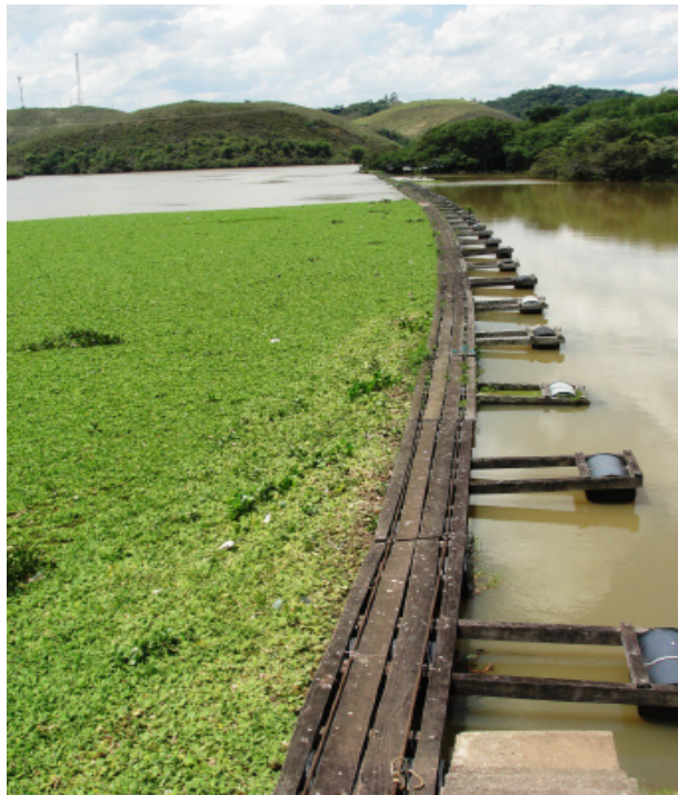
Figura 18 – Foto de uma barreira de contenção. Fonte: Light (2014).
