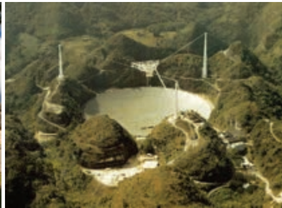
30- Radiobservatório de Arecibo, em Porto Rico, o maior radiotelescópio de prato único do mundo, com 306 m de diâmetro (crédito: Wikimedia Commons).
