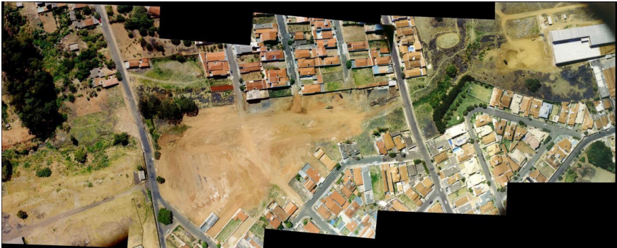
Figura 4 – Foto aérea do trecho tamponado da primeira intervenção.
