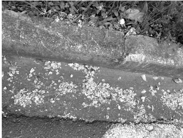
Figura 1 – Fotografia original de um trecho de guia de rua.
