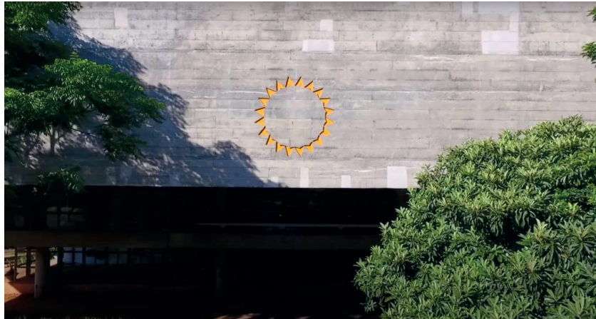
FIGURA 1 Foto empena do edifício da FAUUSP na Cidade Universitária em São Paulo.
