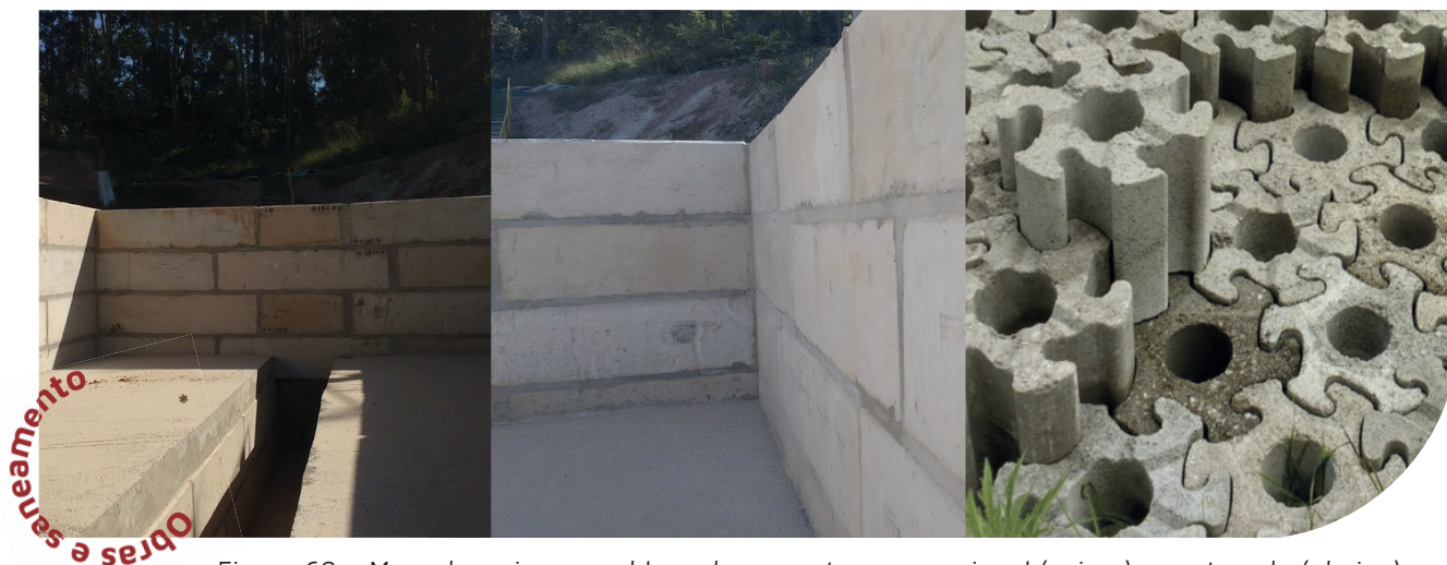
Figura 60 – Muro de arrimo com bloco de concreto, convencional (acima) e sextavado (abaixo). Fonte: ABRECON.
