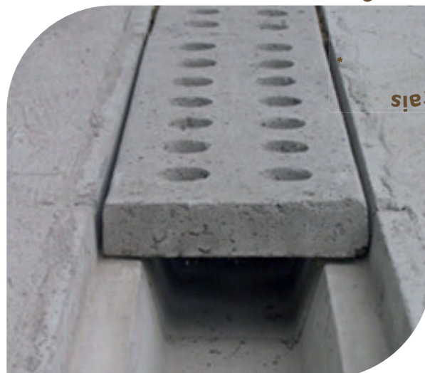
Figura 49 – Grelha perforada, para proteger galeria e aumentar a infiltração de água de chuva pelo solo, através de um piso drenante. Fonte: ABRECON.
