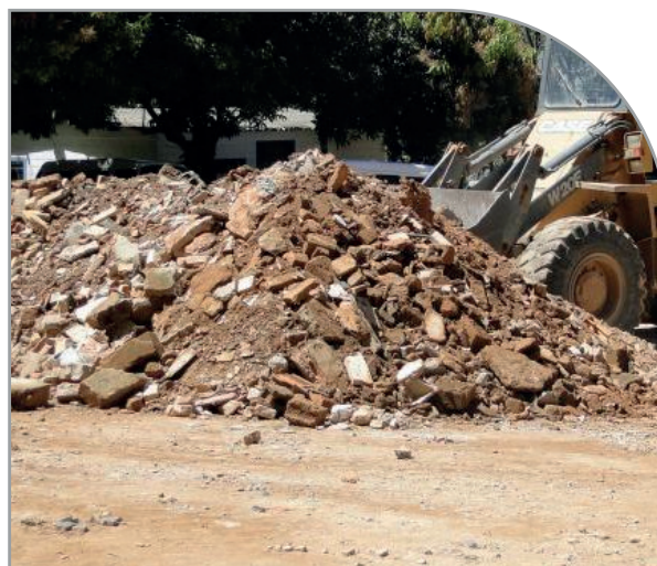
Figura 2- RCD misto: demolição de alvenaria de blocos de cerâmica vermelha, misturado com solo de escavação e diversas impurezas (tubulações de instalações elétricas, de água, madeira, metais). Fonte: google imagens.
