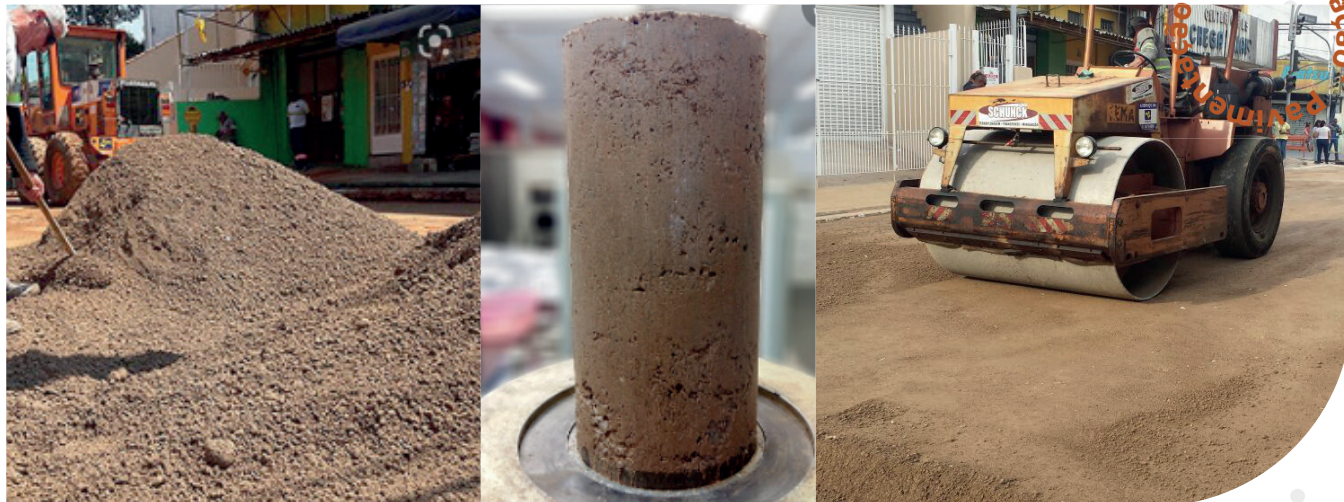
Figura 25 – Brita reciclada mista, tratada com cimento. Finos do ARM podem ser usados para reciclar inclusive o próprio cimento. Fonte: IPT.
