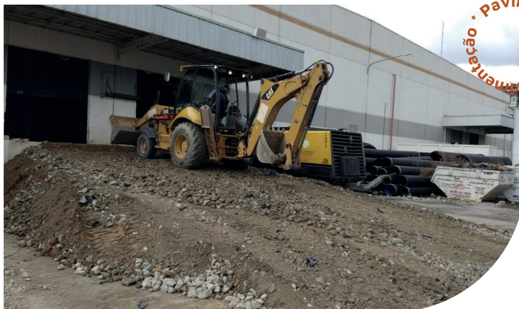
Figura 17 – Vias de acesso provisória em obras de construção civil com AR. Fonte: ABRECON.
