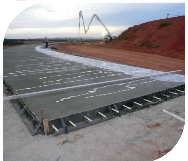
Figura 43 – Piso de concreto armado. Fonte das imagens: google imagens, https://www.concrepav.com.br/concreto-pavimento-rigido
