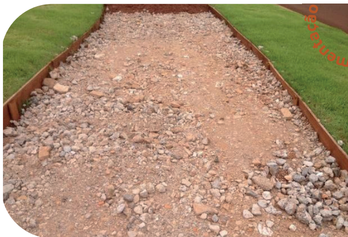
Figura 16 – Revestimentos primários de vias, realizando perenização de estradas de terra. Fonte: ABRECON.
