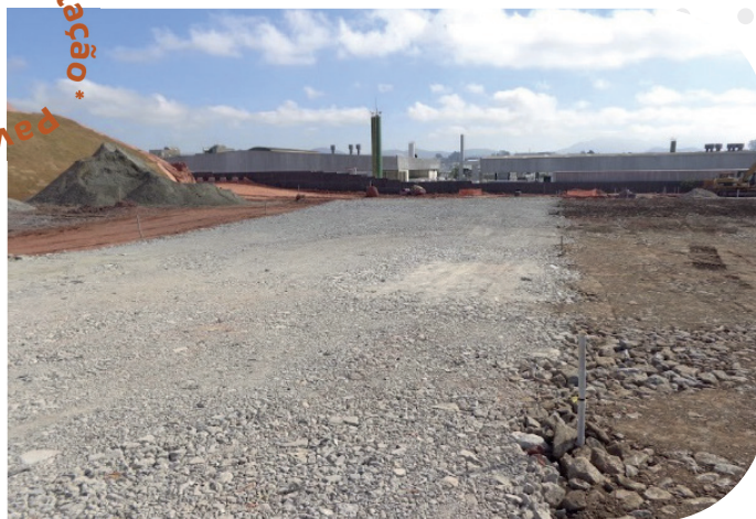
Figura 16 – Revestimentos primários de vias, realizando perenização de estradas de terra. Fonte: ABRECON.
