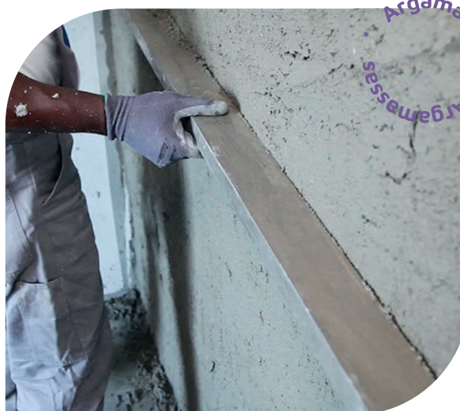
Figura 29 – Revestimento de argamassa: camada única. Fonte: ABRECON.
