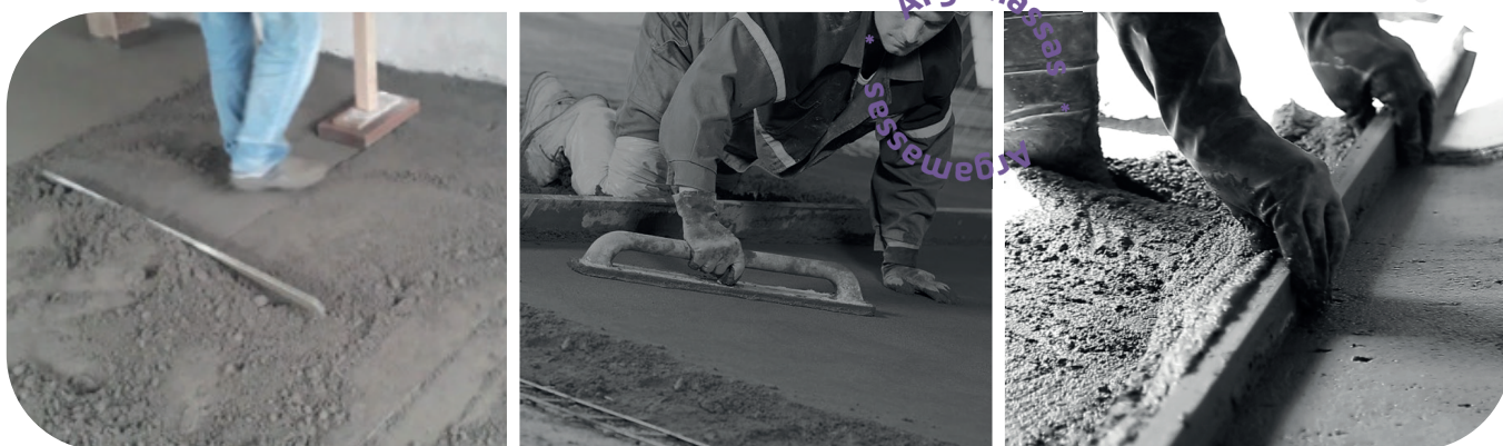
Figura 26 - Execução de argamassa de contrapiso, consistência seca. Fonte: google imagens, ABRECON.
