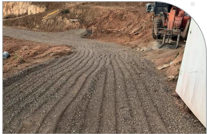
Figura 23- Brita graduada reciclada cimentícia (granulometria, com dimensão inferior a 25 mm) e execução de camada de base. Fonte: google imagens.
