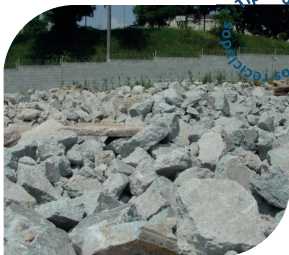
Figura 6 - Resíduo da demolição de um piso de concreto estrutural. Fonte: google imagens.
