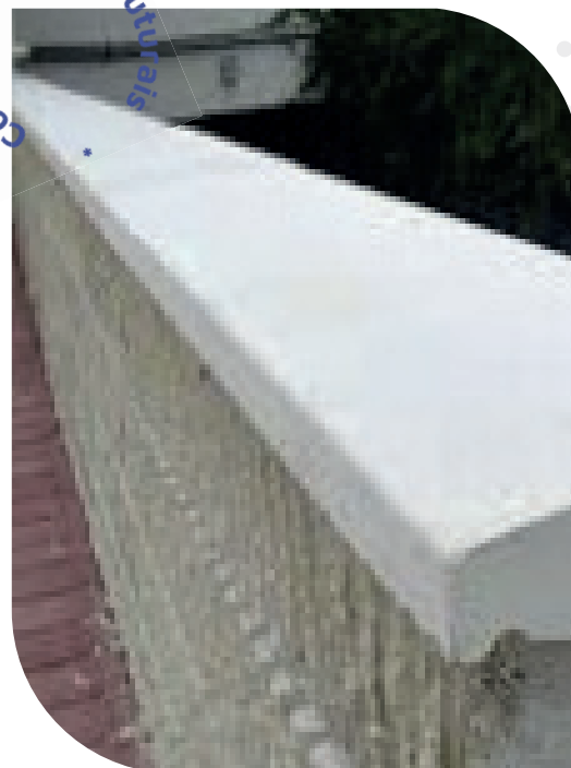
Figura 35 – Rufo de concreto sobre muro. Fonte: ABRECON.
