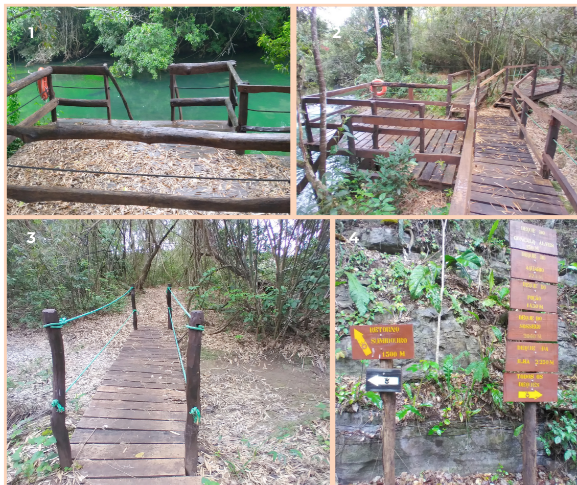
Figura 3. Infraestrutura instalada no PNSB
