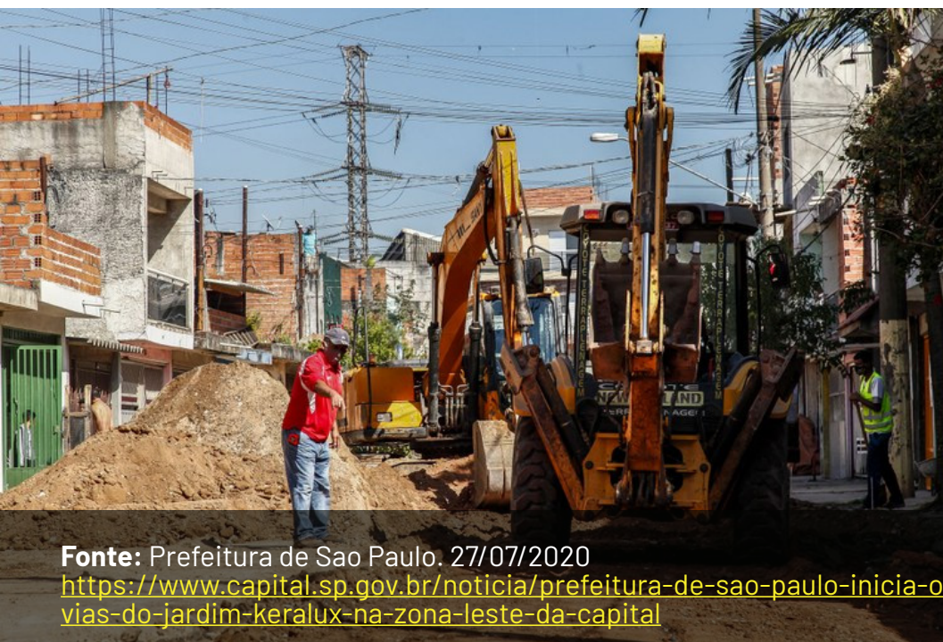
Figura 31: Pavimentação das ruas do Jardim Keralux:
