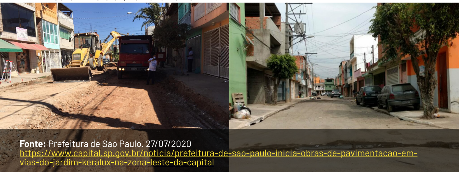
Figura 32: Prefeitura de São Paulo inicia obras de pavimentação em vias do Jardim Keralux, na Zona Leste
