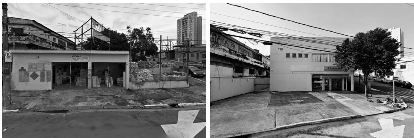
Figura 5 – Antes (à esquerda) e depois (à direita) do imóvel ser transformado na Agência Parque Boturussu.
