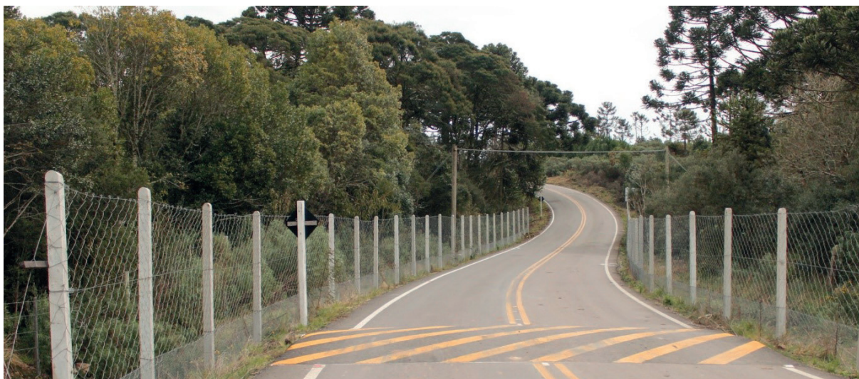
Figura 3 - Cerca instalada para reduzir as colisões entre veículos e fauna.
