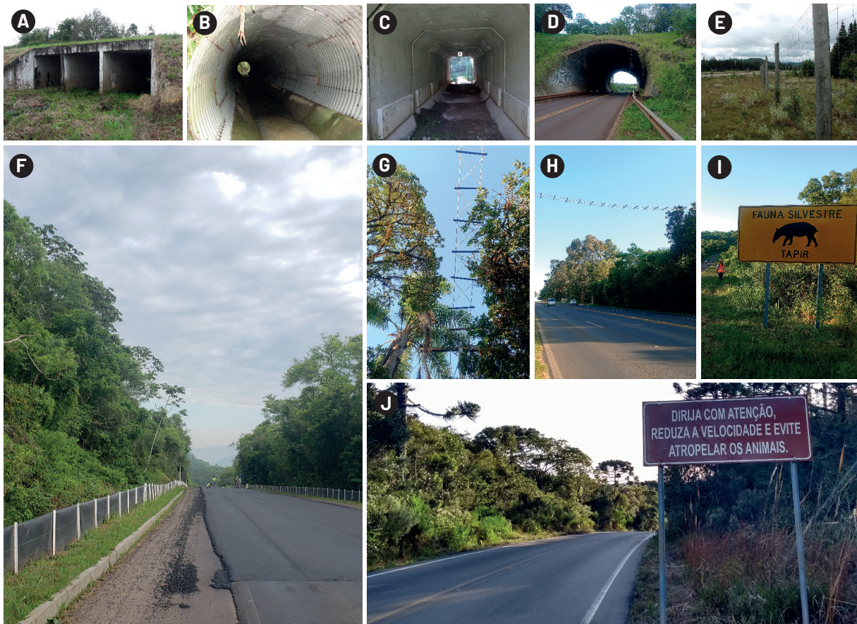
Figura 2 - Exemplos de medidas de mitigação: passagens inferiores de fauna (A, B e C), passagem superior de fauna ou viaduto vegetado (D), cercamentos para fauna de grande (E) e pequeno (F) porte, ponte de dossel (G e H) e placas sinalizadoras (I e J).
