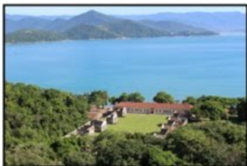
Fig. 4.3 - Ruínas do antigo presídio da Ilha Anchieta que compõem a zona de uso intensivo.
