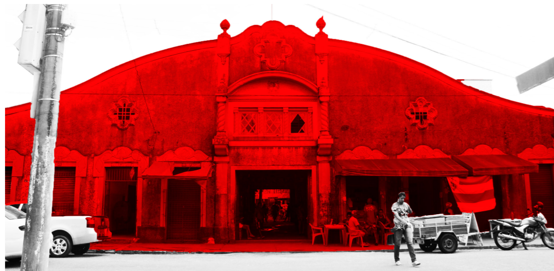
Figura 2: Fachada principal do mercado do Porto do Sal. Foto: C. Chaves, 2014.
