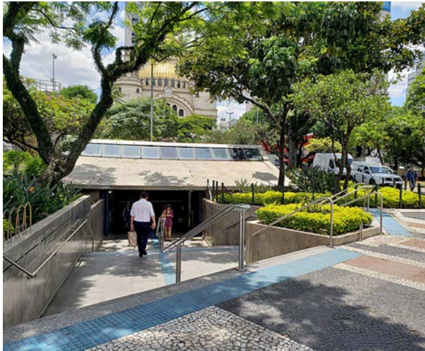
FIGURA 13 Acesso à estação Paraíso.
