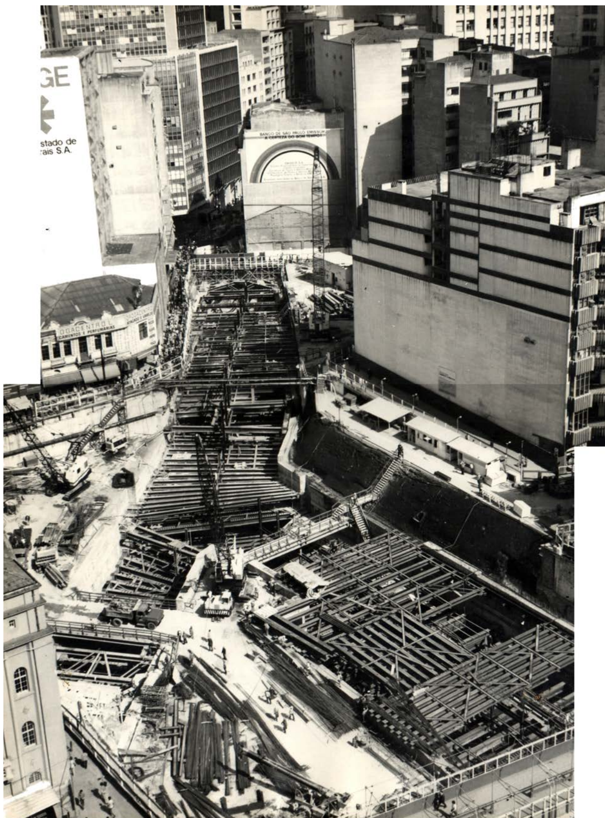
FIGURA 5 Construção do metrô no Largo São Bento, formando fosso a céu aberto.
